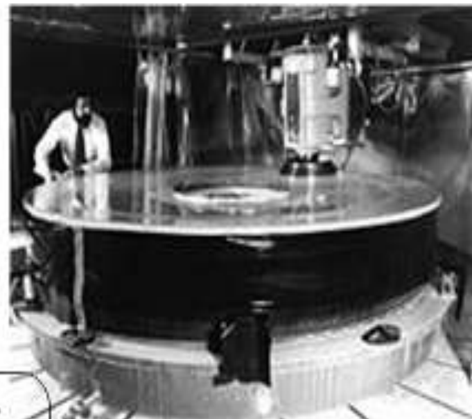
Полировка главного зеркала телескопа, лаборатория компании Перкин-Элмер, май 1979
